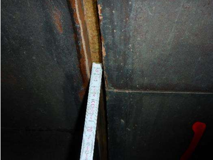
■ Nach Rückbau und Säuberung der Fugen wurde die Fugentiefe gemessen. (Link zum hochauflösenden Photo )
