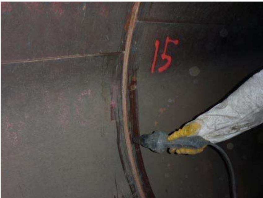
■ Trocknen der Fugenflanken (Link zum hochauflösenden Photo )
