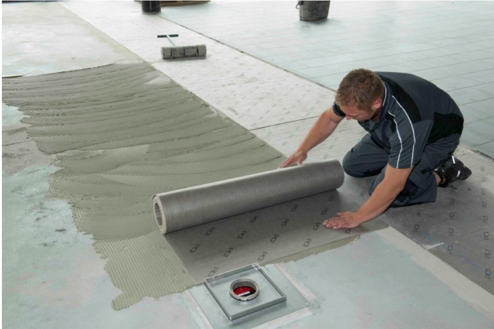
Für die Trittschalldämpfung im Autohaus sorgt die Entkopplungsmatte PCI Pecilastic E im Bodenaufbau.
