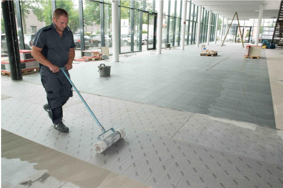
Mit dem Fliesenkleber PCI FT Klebemörtel wurde die Entkopplungsmatte PCI Pecilastic E fachgerecht verklebt.
