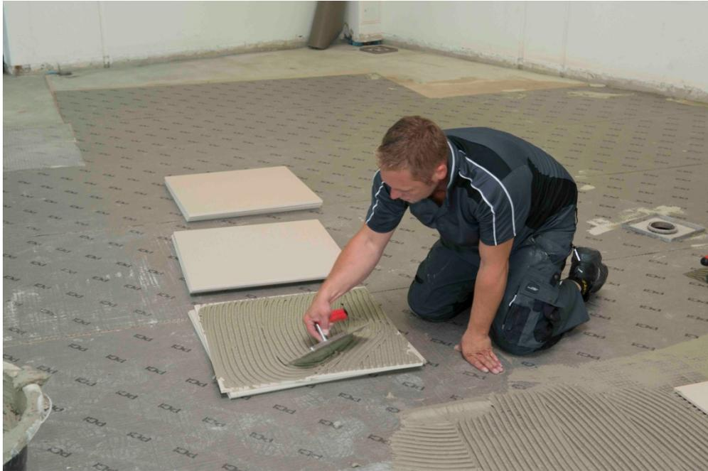
Die Verlegung der anthrazitfarbenen und beige Fliesen aus dem Hause Casalgrande erfolgte mit dem Fliesenkleber PCI FT Klebemörtel auf einer Fläche von rund 2.000 m<sup>2</sup>.
