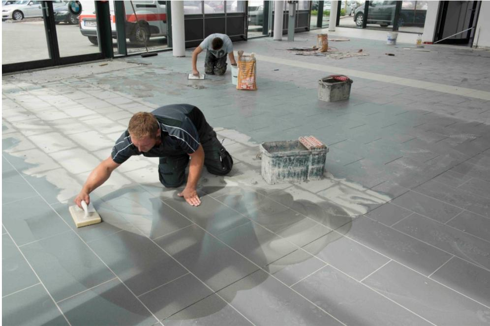
Verfugt wurden die Fliesen mit PCI Megafug. Die geschmeidige Fugenmasse lässt sich einfach verarbeiten und ist bereits nach zwei Stunden begehbar.
