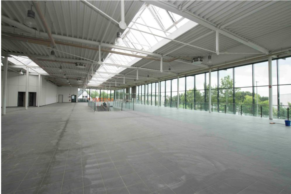
Die Erneuerung des Bodenbelages dauerte nur vier Wochen: Auf den zwei Geschoßen des Autohauses wurde der alte Estrich entfernt, ersetzt und die neuen Fliesen auf dem gut vorbereiteten Untergrund verlegt.
