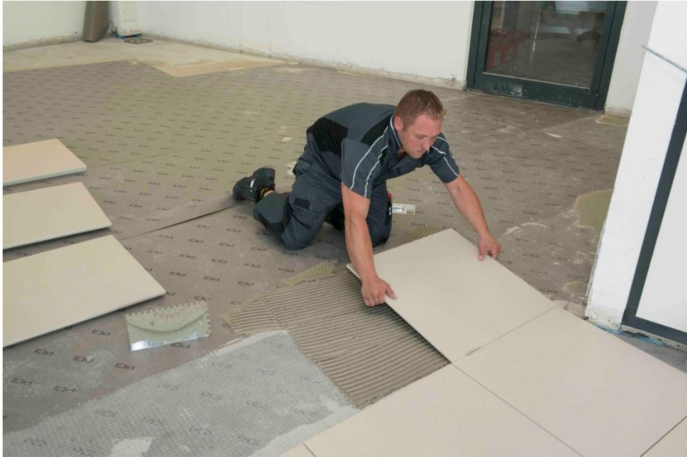
Auf Fliesenrückseite und Bodenuntergrund brachten die Fliesenleger PCI FT Klebemörtel für die Verlegung auf.
