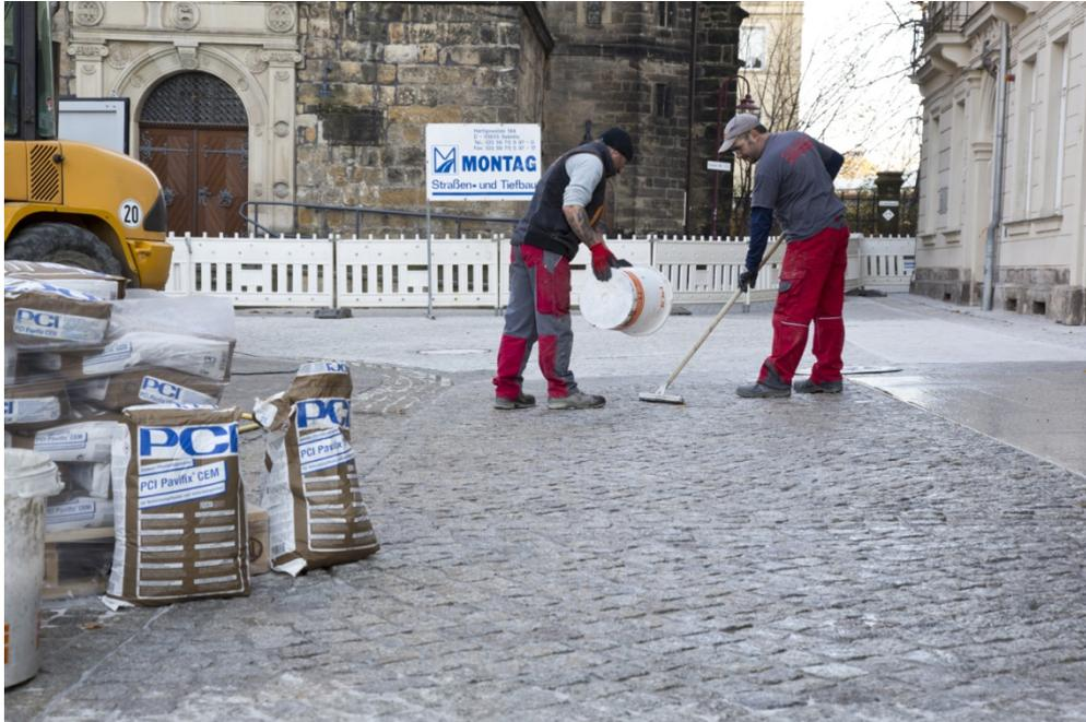
Das Verfugen mit PCI Pavifix CEM erfolgte im Schlämmverfahren: Der fließfähige Fugenmörtel wurde auf die vorgemastete Pflasterfläche aufgebracht, mit einem harten Gummischieber verteilt und in die Fugen eingebracht.
