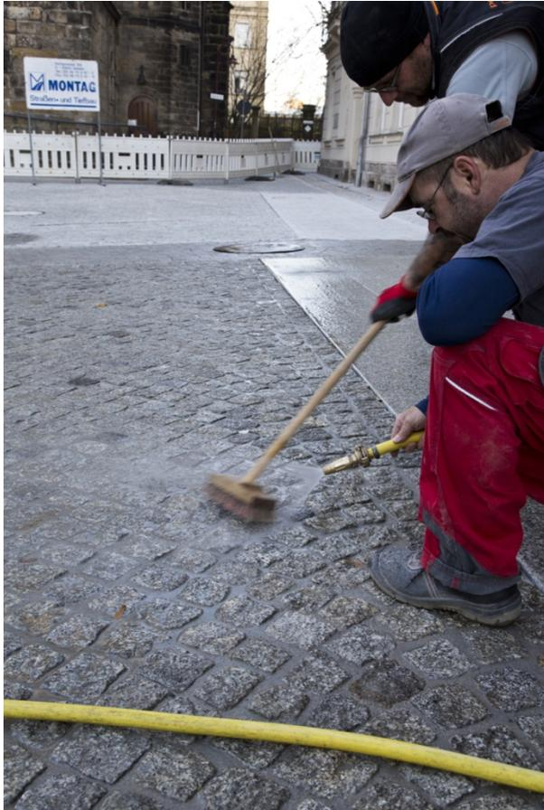
Die Oberfläche wurde durch horizontales Abspritzen mit einer Flachstrahldüse gereinigt. Restmaterial wird durch den Fächerstrahl einfach entfernt und nur die Oberfläche abgespült. Ein Verwässern des ohnehin sehr kompakten Fugenmörtels lässt sich dadurch vermeiden.
