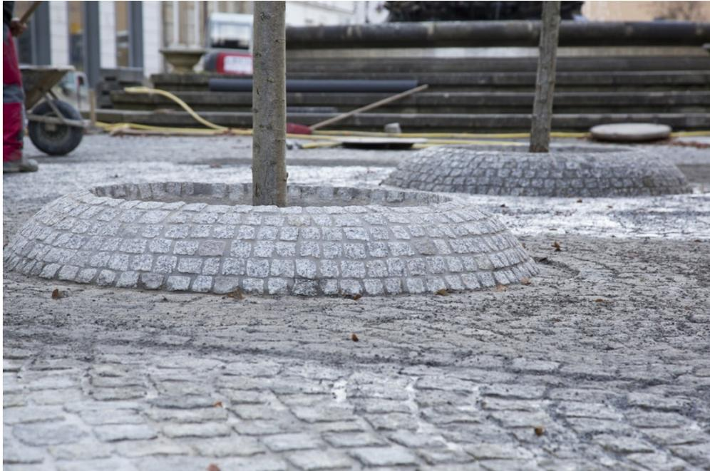
Die Aussparungen für die Baumbepflanzung wurden formschön gestaltet und professionell mit dem standfesten Fugenmörtel PCI Pavifix CEM ROC ausgeführt.
