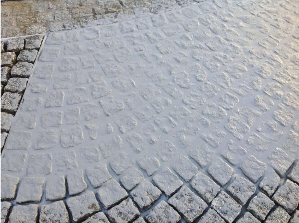
Dank der leicht verlaufenden Konsistenz lässt sich PCI Pavifix CEM einfach in die Fugen einbringen. Geeignet ist der Zement-Pflasterfugenmörtel für Fugenbreiten ab 5 mm.
