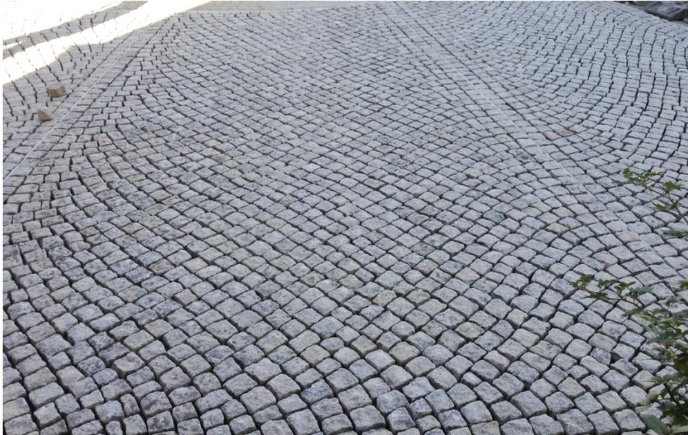
Stephan Montag verlegte mit seinem Team Granitpflaster auf rund 2.000 m<sup>2</sup> Fläche. Die Pflastersteine 10/10 wurden mit der Unterseite in PCI Repahaft getaucht und dann auf Drainmörtel verlegt. Diese Vorgehensweise sorgt für eine hohe Verbundsicherheit.
