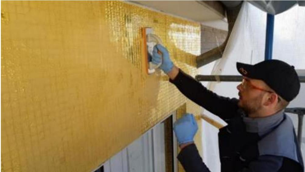
*PCI Durapox<sup>®</sup> Premium Multicolor lässt sich dank cremiger Konsistenz so einfach einbringen wie zementärer Fugenmörtel. [Link zum hochauflösenden Photo](#)*
