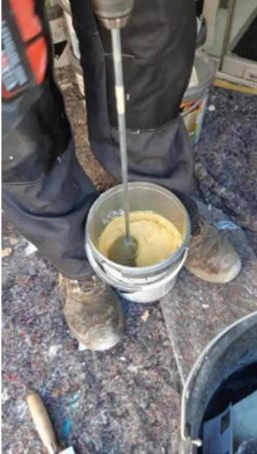
Zur Verlegung des Mosaiks verwendeten die Verarbeiter PCI Durapox NT plus, zum Verfugen PCI Durapox Premium Multicolor im genau zum Mosaik passenden goldgelben Farbton. [Link zum hochauflösenden Photo](#)
