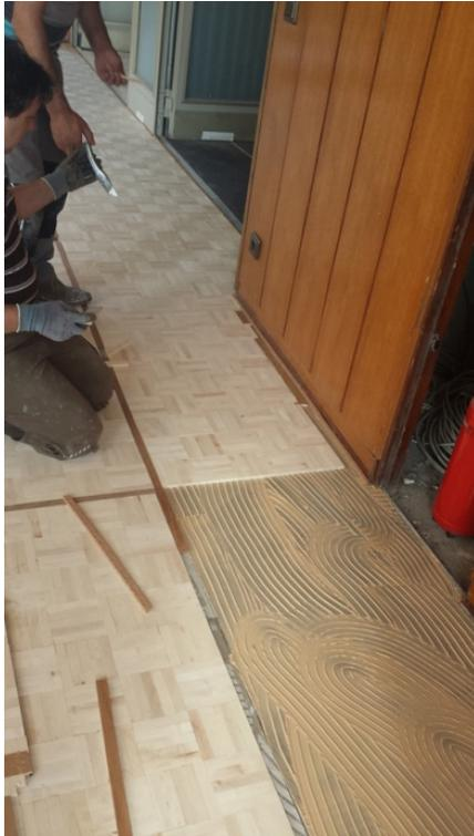
Nach Besichtigung des Untergrundes und Prüfung des alten Gussasphalts stellte PCI-Fachberater Stefan Schweizer die erforderlichen Produkte für die Sanierung zusammen. Verklebt wurde das Würfelparkett mit dem wasserfreien SMP-Parkettkleber PCI PAR 365, der Belastungen und das Abschleifen bereits nach 24 Stunden erlaubt.
