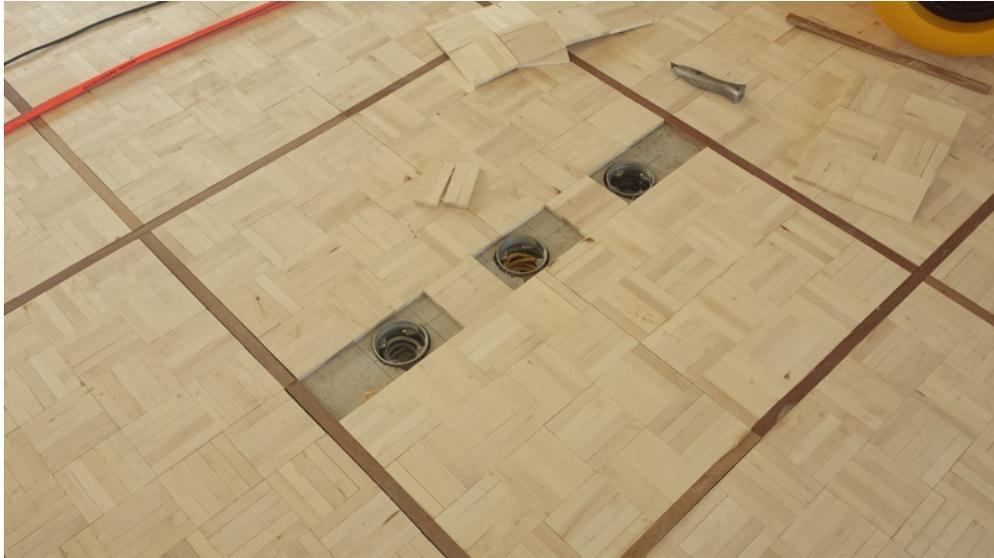
Anschließend grundierte das Team vom Raumstudio Stern die gesamte Fläche mit dem Universal-Vorstrich PCI VG 2 und verteilte, nach einer Trocknungszeit von nur rund 60 Minuten, die zementäre Spachtelmasse PCI USP 32 S.
