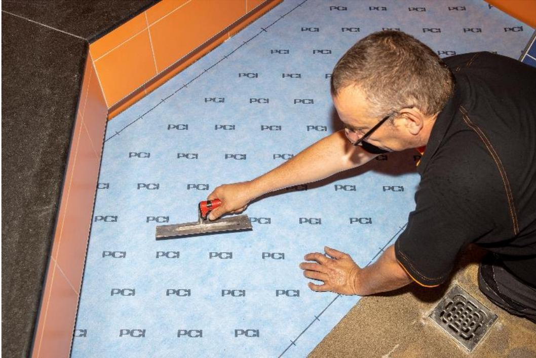
Als Dampfbremse am Boden verklebte der Handwerker die flexible Abdichtungsbahn PCI Pecilastic<sup>®</sup> W mit dem Flexmörtel PCI Nanolight<sup>®</sup>. Darauf kann der Belag direkt verlegt werden.
