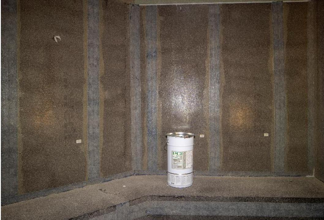
*Für die Abdichtung der Wände wurde PCI Apoflex<sup>®</sup> W zweimalig aufgetragen und bei der zweiten Schicht mit Quarzsand abgesandet.
